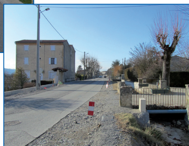
Travaux en cours à Mirabel et Blacons
