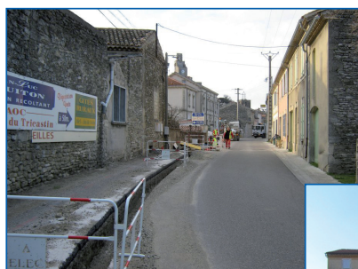
Lors des travaux de Chamaret
