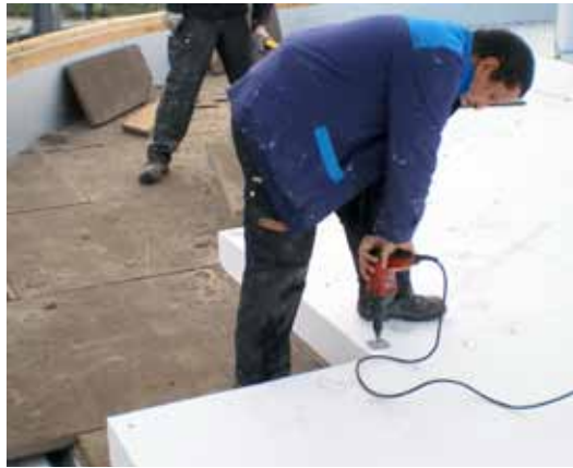
Isolation d'un toit terrasse
