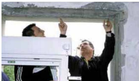
Remplacement de menuiseries isolantes
