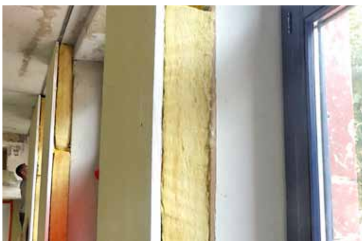
Doublage isolant épais (16cm)
