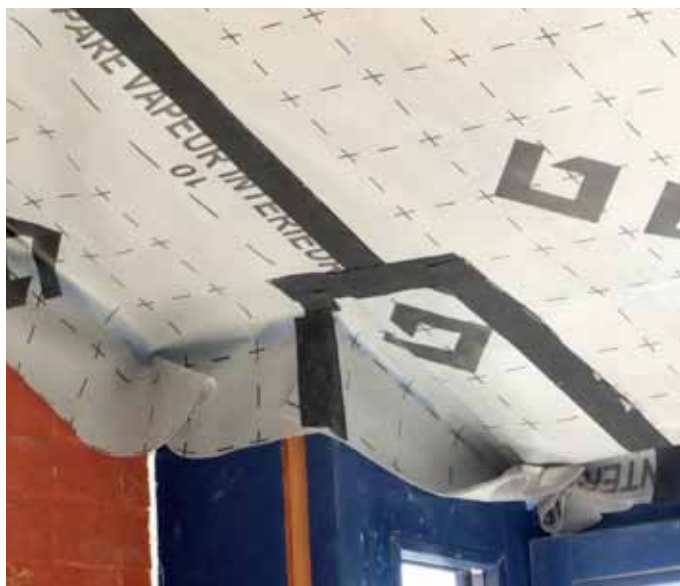
Pose d'un écran pare-vapeur étanche à l'air
