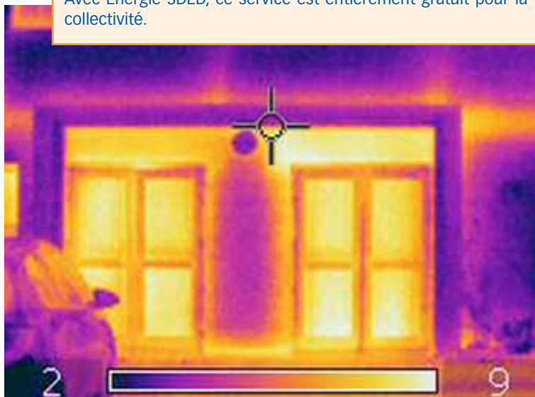
Camera thermique pour identifier les déperditions de chaleur
