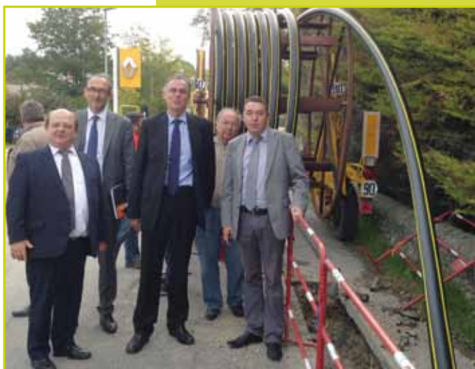
Premières poses de canalisations
