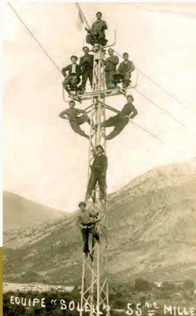
JUCHÉS SUR UN PYLÔNE, LES MONTEURS DE L'ÉQUIPE «SOLEIL», AU SECOND PLAN, LA VALLÉE DE L'EYGUES. DATE : 1920~1925
