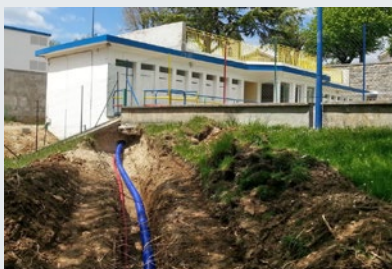
La jonction entre l'école et la piscine
