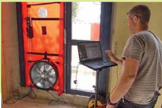
Test d'étanchéité à l'air
