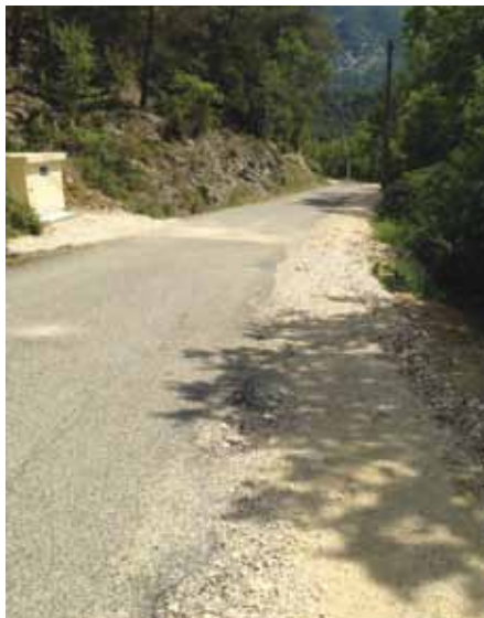
Après travaux, nouveau poste «le village»
