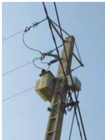
Transformateur «le village» avant les travaux
