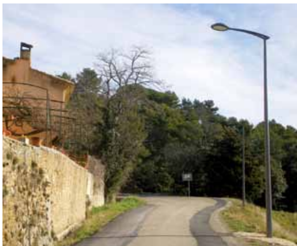
Candélabre « traditionnel » d'éclairage routier mais bénéficiant de la technologie LED
